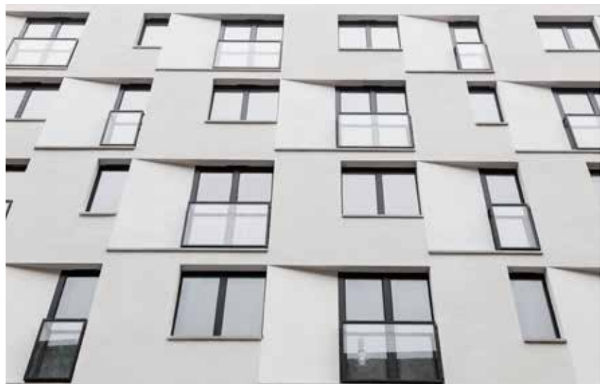
... und nach der Fertigstellung im Jahr 2014.
