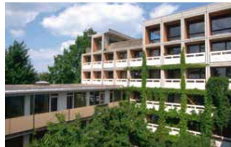
Die Wohnanlage „Weihenstephan I“ in der Vöttinger Straße in Freising.
