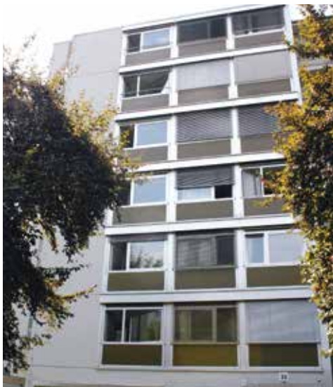
Die Außenfassade des Internationalen Hauses vor dem Neubau ...
